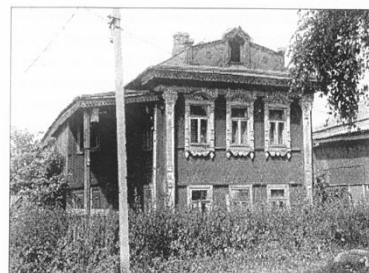
Дом жилой. Фото 1999 г.
